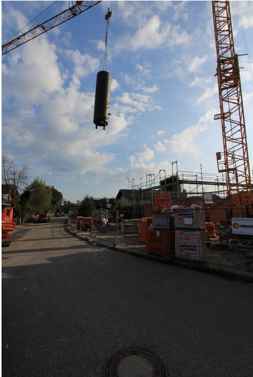
Der Pufferspeicher dient im Sonnenhaus als zentraler Energiespeicher und ermöglicht die hohe Deckung mit solarer Wärme.
